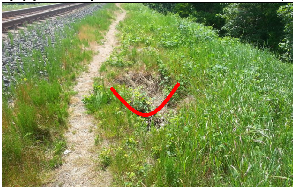
Obrázek č. 9: Km 50,380, pravá strana (ve směru staničení); propad v povrchu koruny násypového tělesa svědčící o podpovrchovém odnosu materiálu – tzv. sufoze; Foto autor
